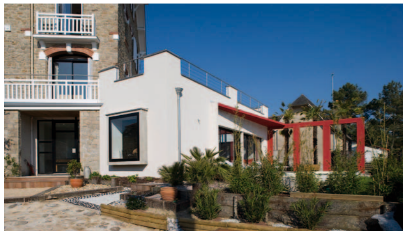
Liaison de la maison avec l'extension
